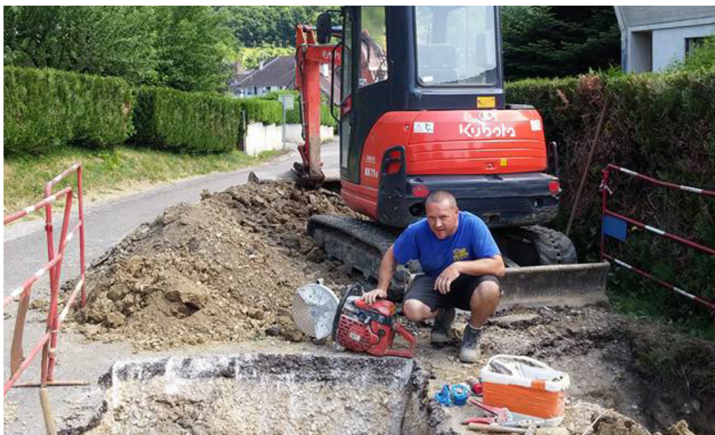
En 2015 changement des canalisations en plomb
